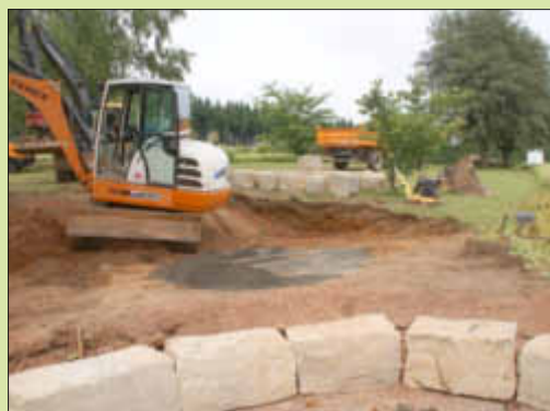
Bauarbeiten im Globusgarten
