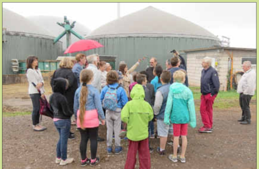
Besichtigung der Biogasanlage
