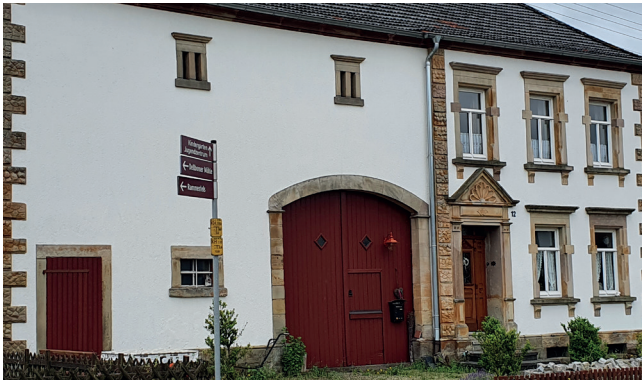
Positiv: Stilgerechte Sanierung der Fassade
