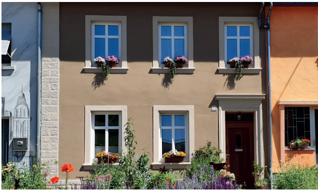
Positiv: Stilgerechte Sanierung der Fassade
