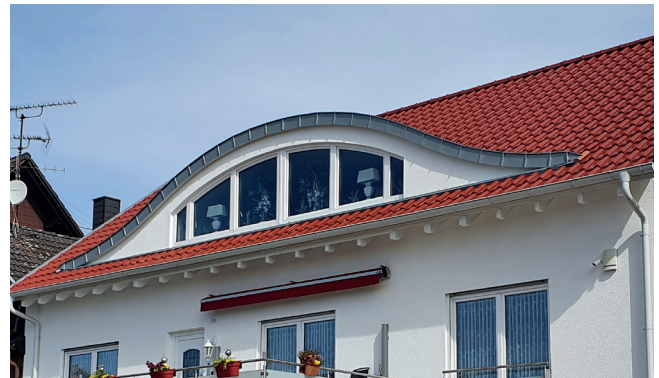
Negativ: regionaluntypische Dachgaube
